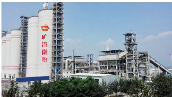
**成品仓：**6个矿渣微粉成品仓，存储能力高达50000吨，可容纳10辆车同时装货。
