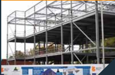
建筑行业 Construction
