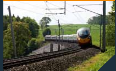
铁路 Rail Infrastructure
