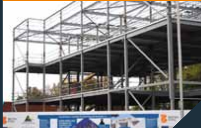
建筑行业 Construction
