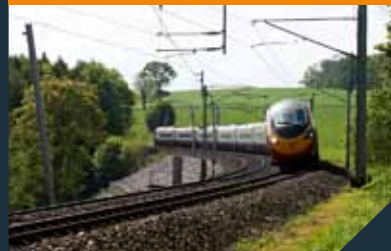
铁路 Rail Infrastructure
