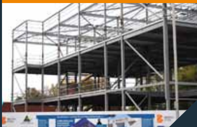
建筑行业 Construction
