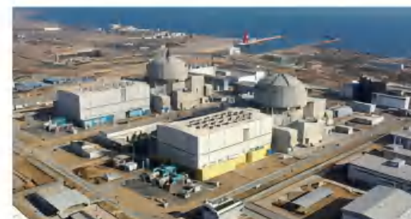
巴基斯坦卡拉奇核电站 Karachi Nuclear Power Station, Pakistan
