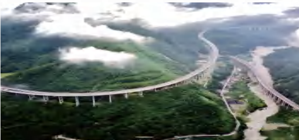
平镇高速工程
