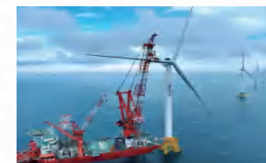
明阳金山海上风电管桩项目 Mingyang Jinshan Offshore Wind Power Pile Project
