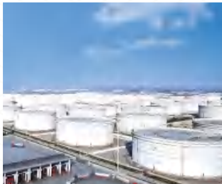
大型原油储罐
