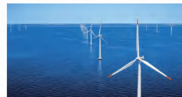
华电丹东东港一期100万千瓦海上风电项目 Huadian Dandong Donggang Phase I 1,000 MW Offshore Wind Power Project
