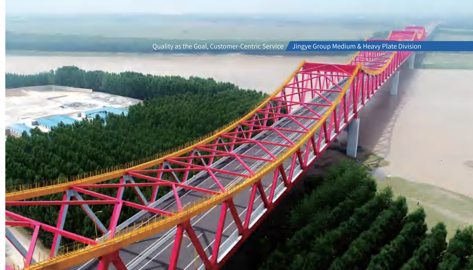
长清黄河公路大桥
