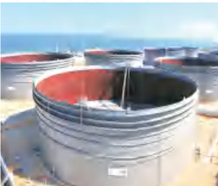
大型原油储罐
