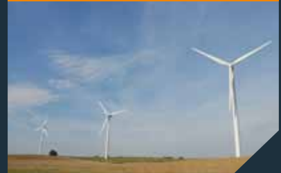
能源和电力 Energy & Power
