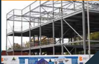
建筑行业 Construction
