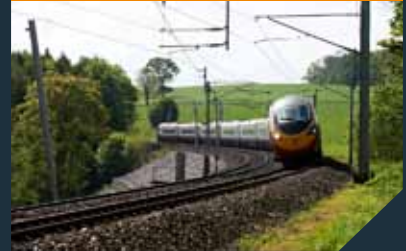
铁路 Rail Infrastructure
