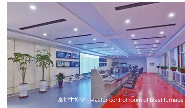
高炉 Blast furnace
