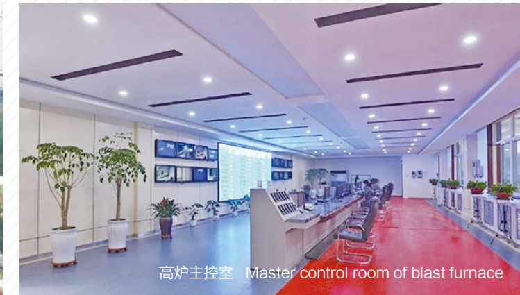
高炉 blast furnace
